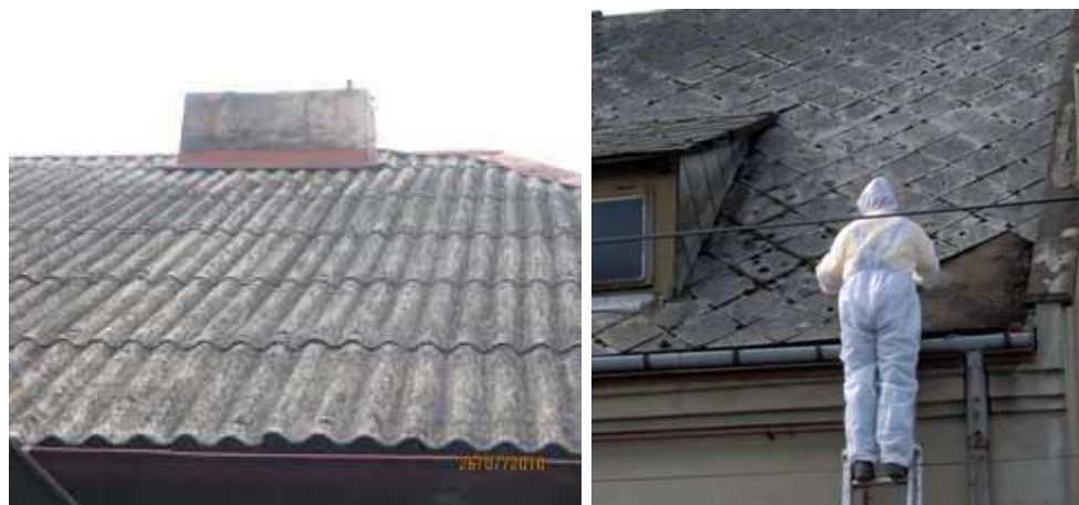
Ryc. 14. Rodzaje wyrobów zawierających azbest. Po lewej - płyty dachowe faliste (W02), po prawej - płyty azbestowo - cementowe typu „karo” (W01) Źródło: www.wizja24.pl , www.zgpd7.pl .
